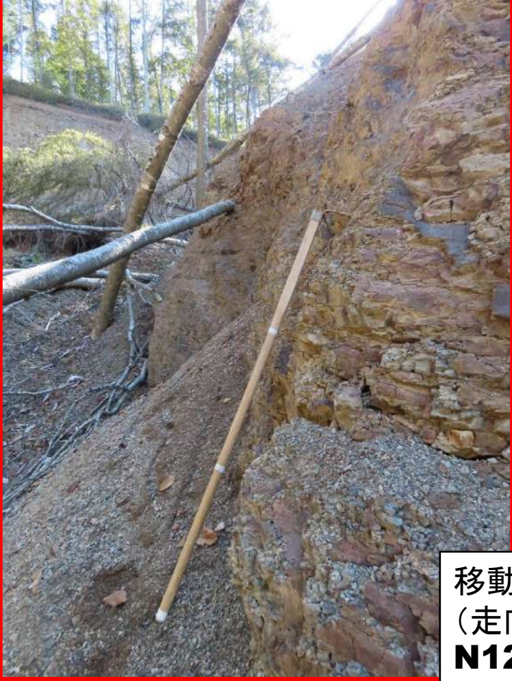
図9 崩壊地写真32 (2020. 10.11撮影)
