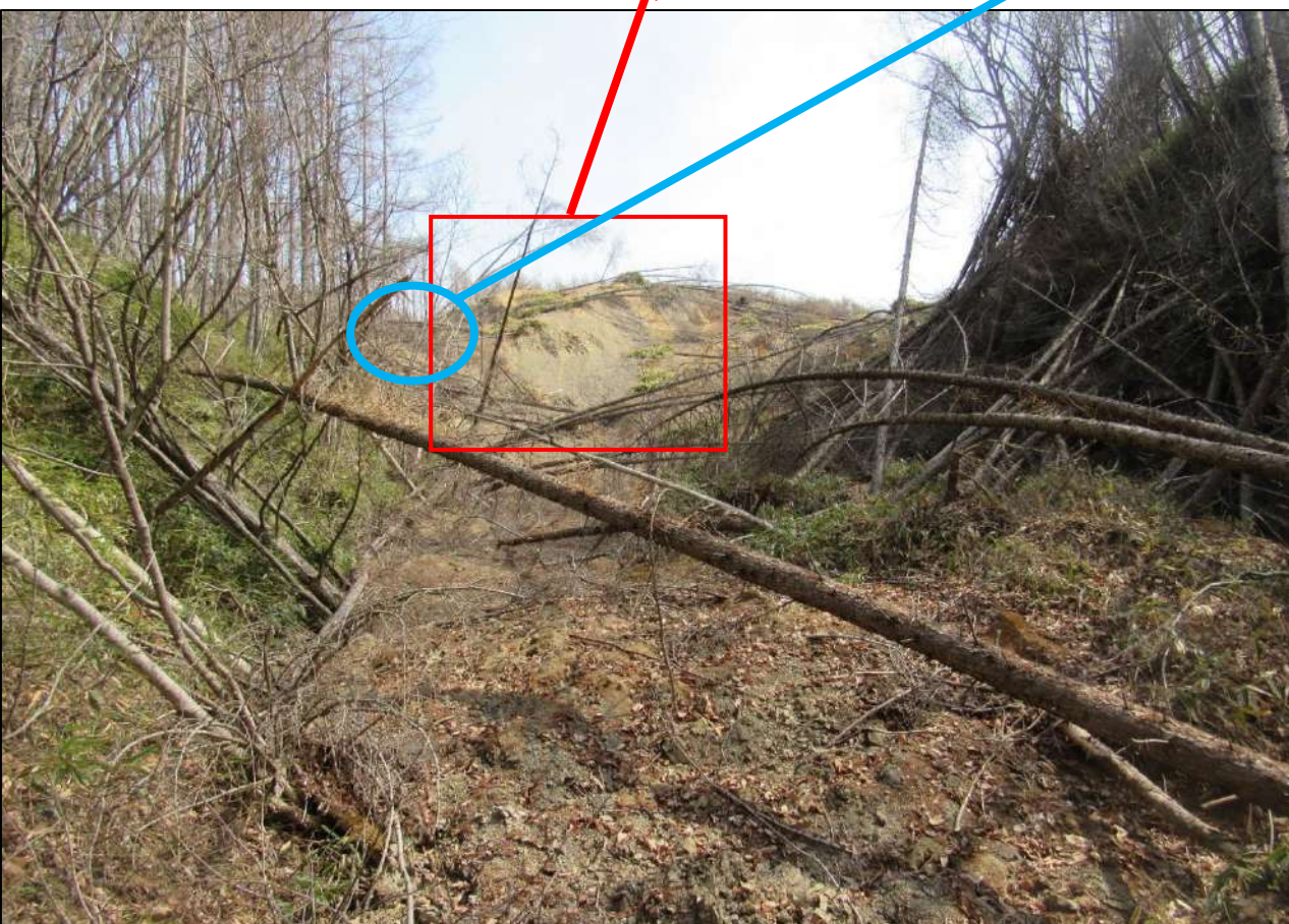
枝沢内下流から岩盤すべり下手(移動部)をとらえる
