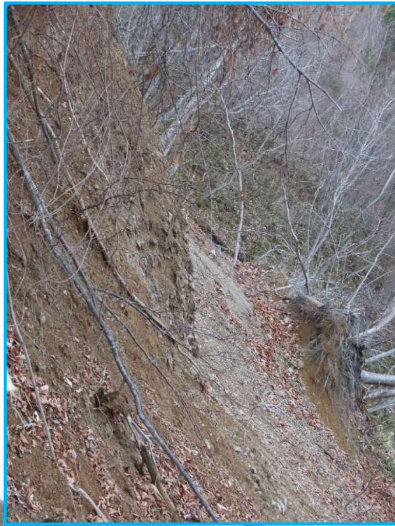
図6 斜面東端一谷側一の急崖部 (岩盤崩落)
