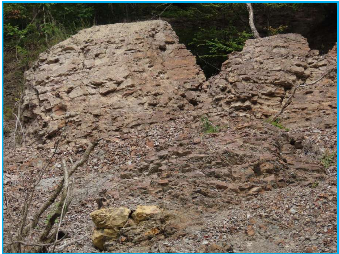
岩盤すべり状の崩落岩盤ブロック
