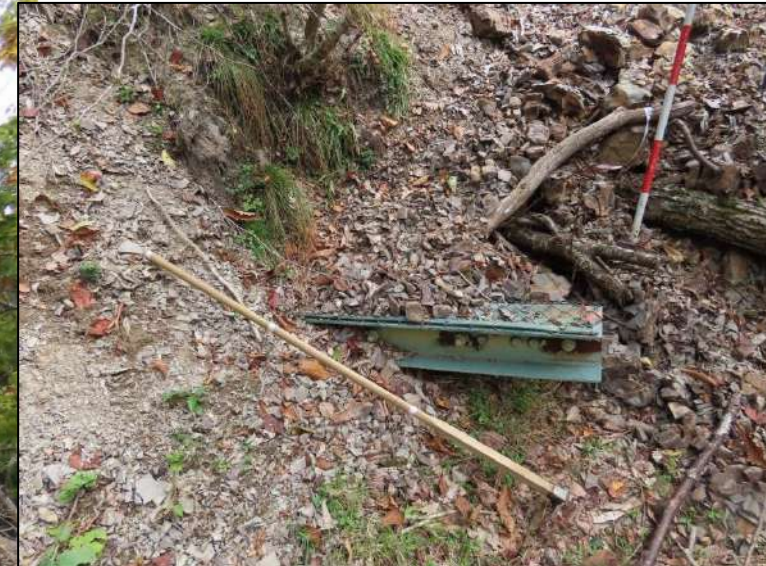
転倒した鋼製擁壁
