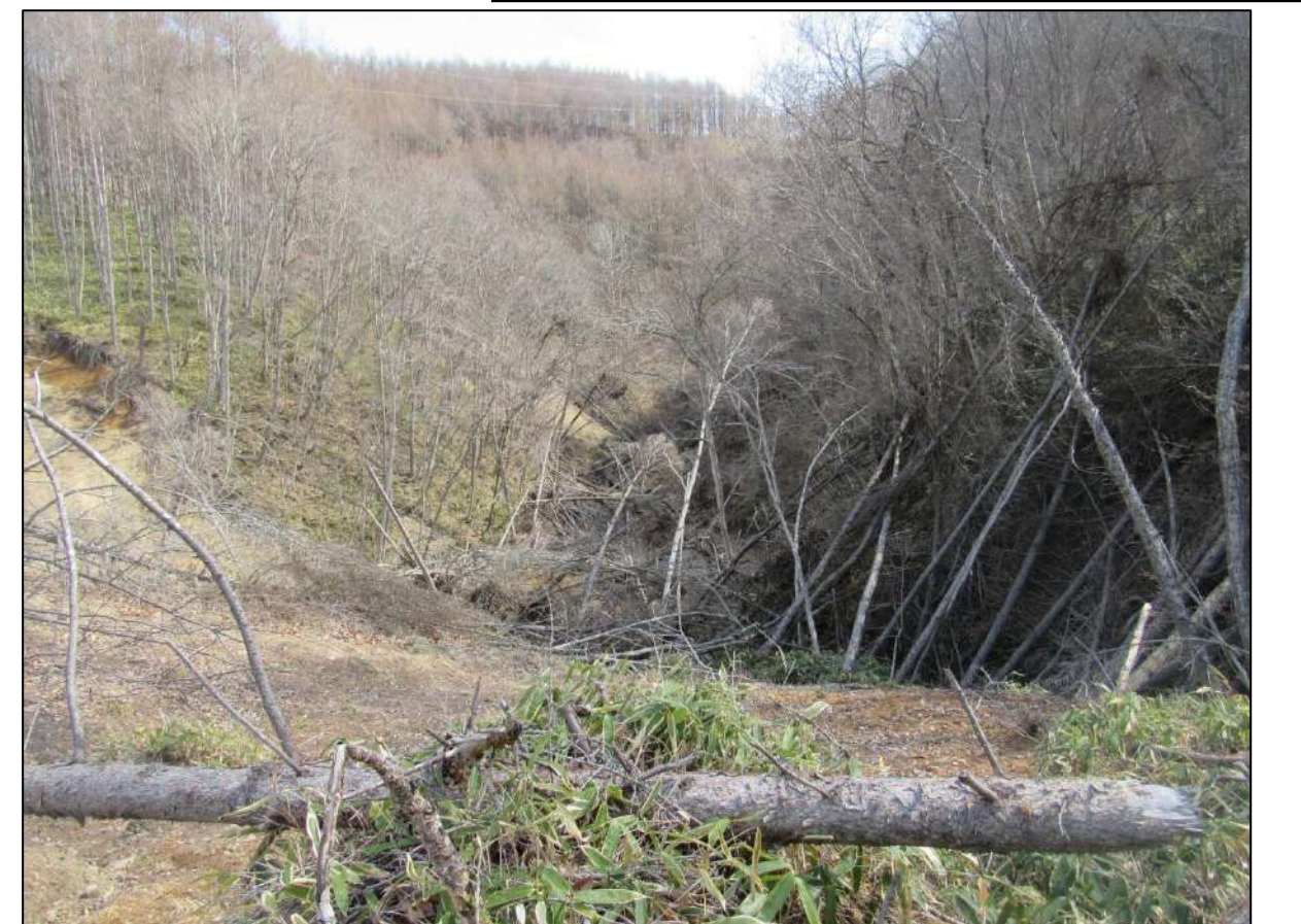
移動体が沢を塞ぎ奥に堰き止め部が生じる
