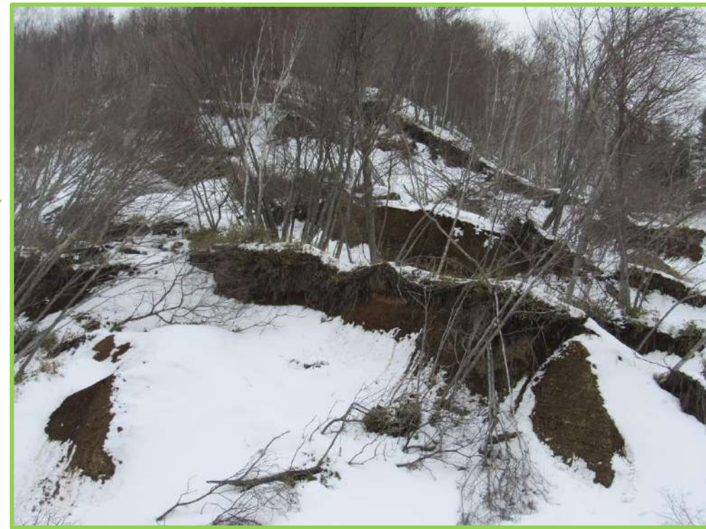
図13 崩壊地西端の写真集(2020.3.4撮影)
