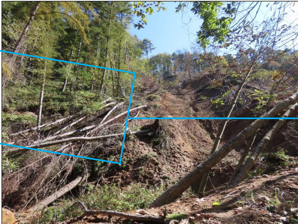
崩壊地末端部(谷底)の状況
