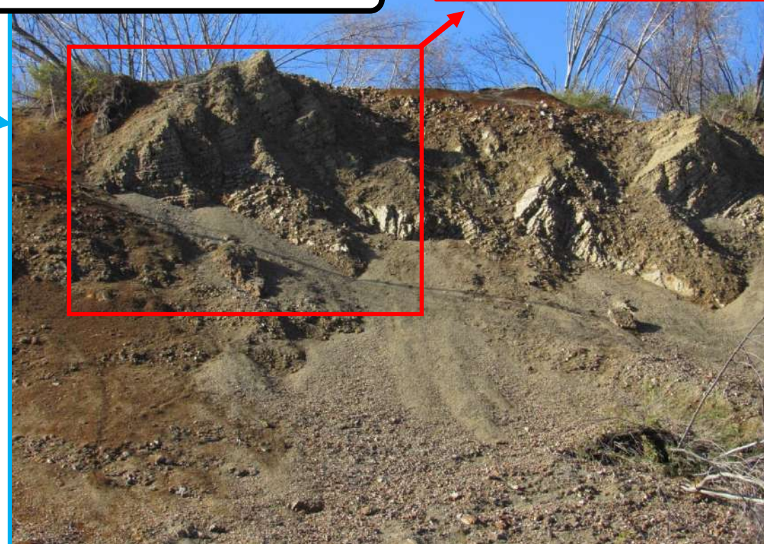
N 箇所(岩盤ブロック化・押し出し)
