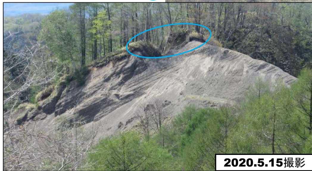
図9 B 箇所(林道 崩壊部;流れ盤)
