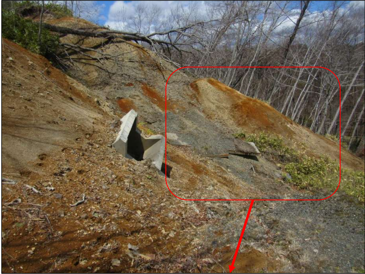
図16 C箇所の写真集2(崩壊・流出した林道:崩壊地末端急斜面上端) -2020.4.24撮影-
