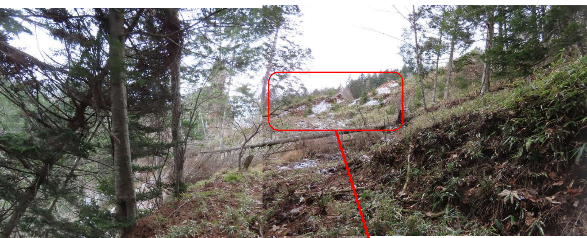
図25 崩壊地中部(B 箇所)写真集 —北側から2020.11.29 撮影—
