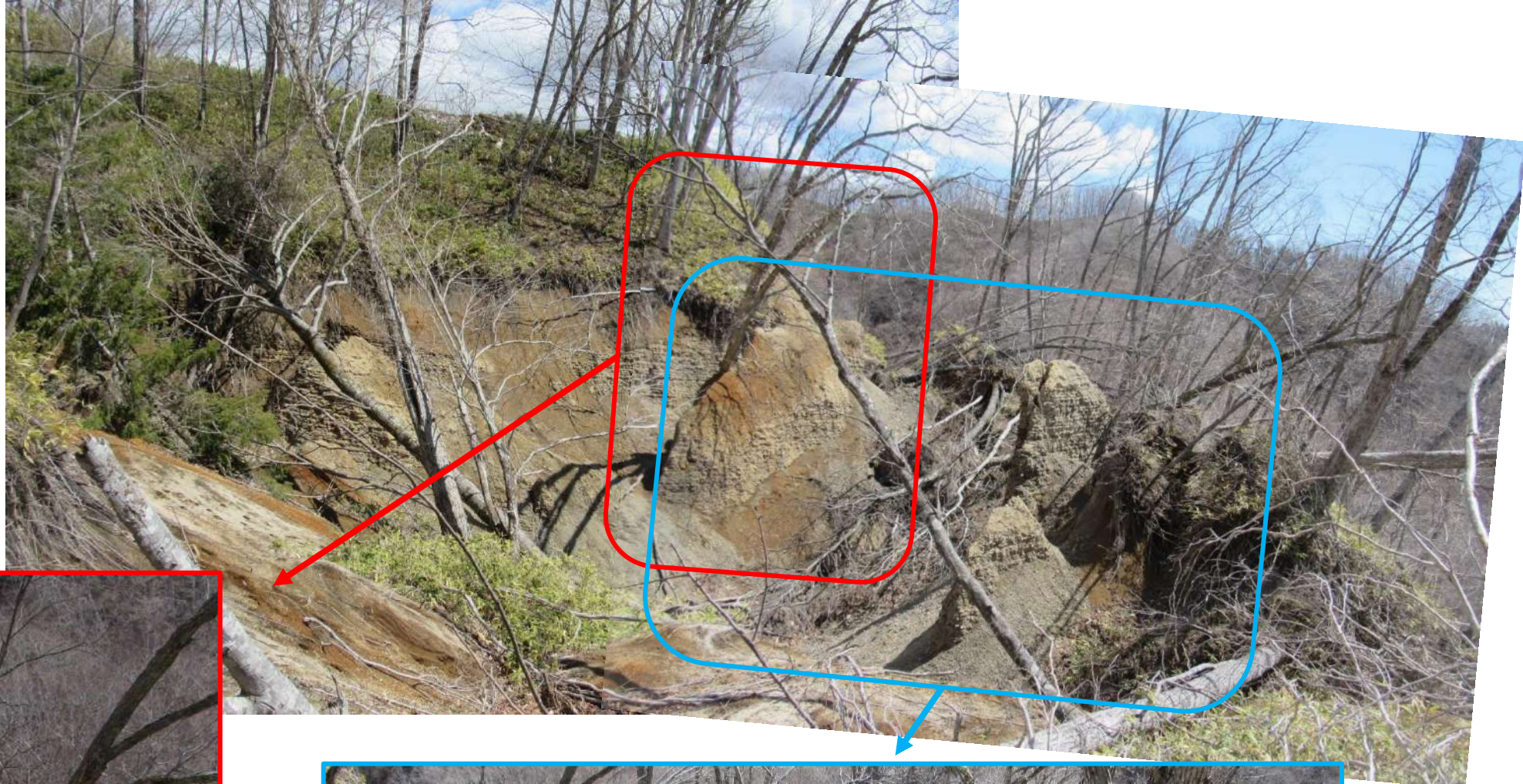
図24 E箇所の写真集 3(南西側急崖の崩壊) —2020.4.24撮影—
