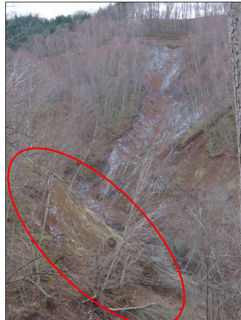
図6 北側から側面を撮影 (2020.11.29)
