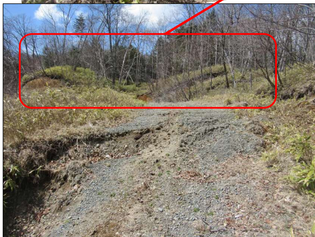
前スライド右上の写真の林道を前方へ進むと路面は引っ張りが働き、道路に直交に亀裂が走り、凸凹。
