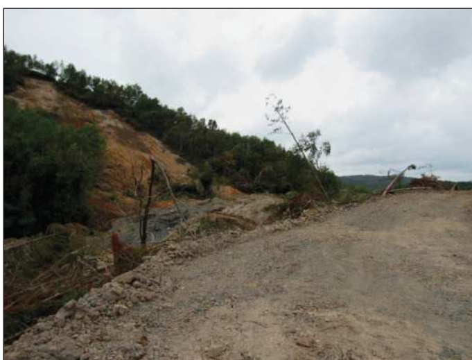
峠付近(南側斜面との接触部)
