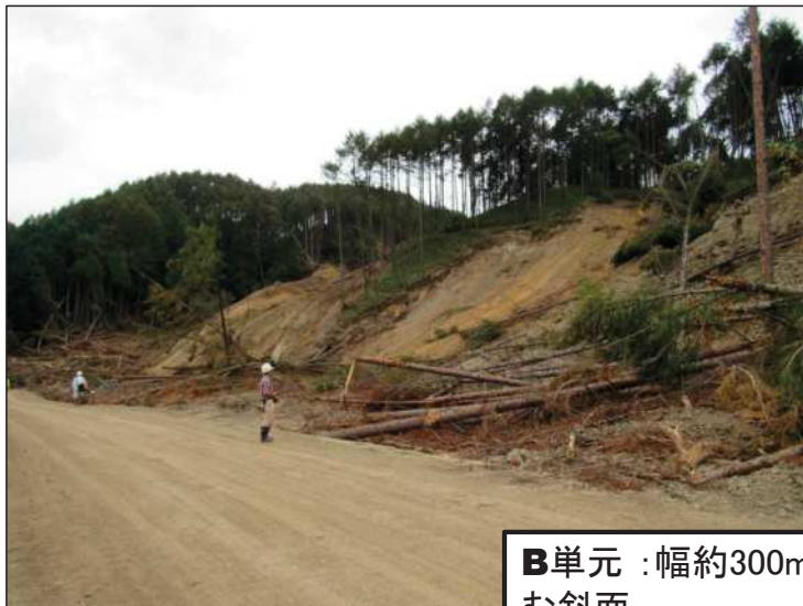
下の写真の赤枠部分の拡大写真。新第三系軽舞層泥岩部も崩壊している。
