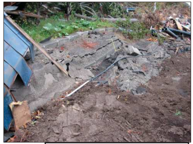
中央部付近で路盤が南へ移動(写真山側路肩コンクリート部)
