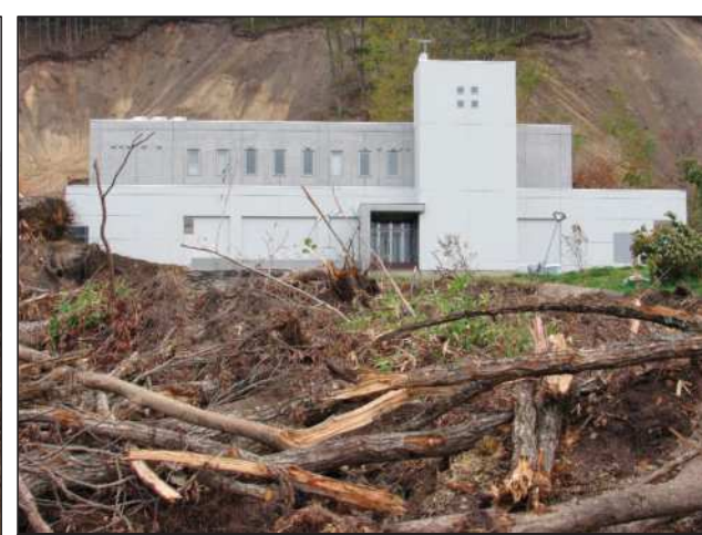
周囲を崩落地すべり体に囲まれた浄水施設棟(上:正面、左上:背後、左下:西側側面)
