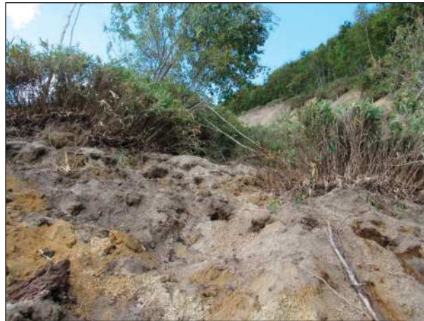
左写真の赤丸囲み内の棚状部から西側を撮影(9月29日撮影)
