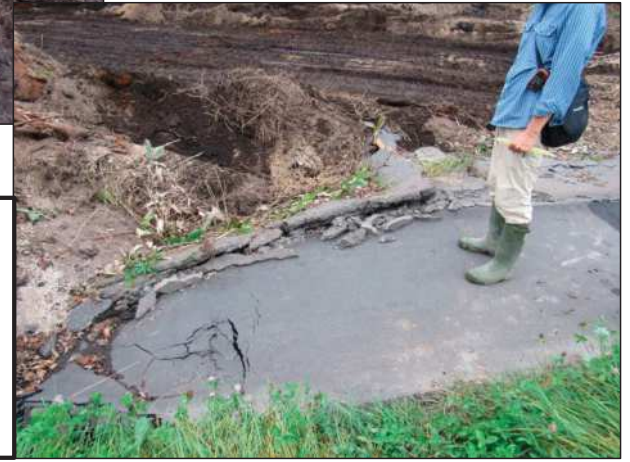
左斜め上の写真の右下右側部分の写真(上部の腐植土部分は路盤が流出した)
