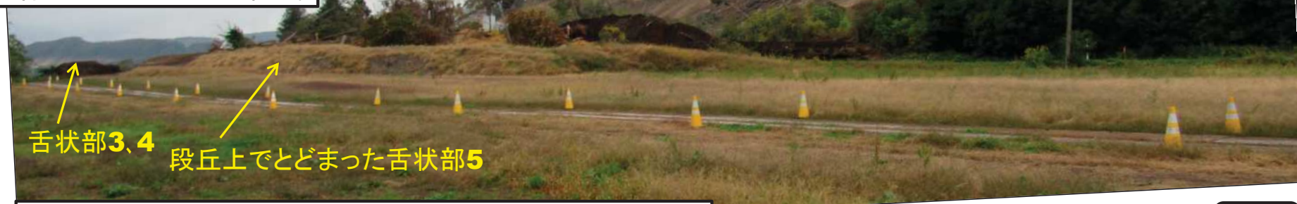
富里給水地付近崩壊・地すべり箇所を東南東からとらえる。
