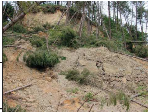
左写真の赤丸囲みの崩落地(西岸)
