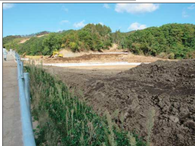
橋南東側取付部から沢口を望む
