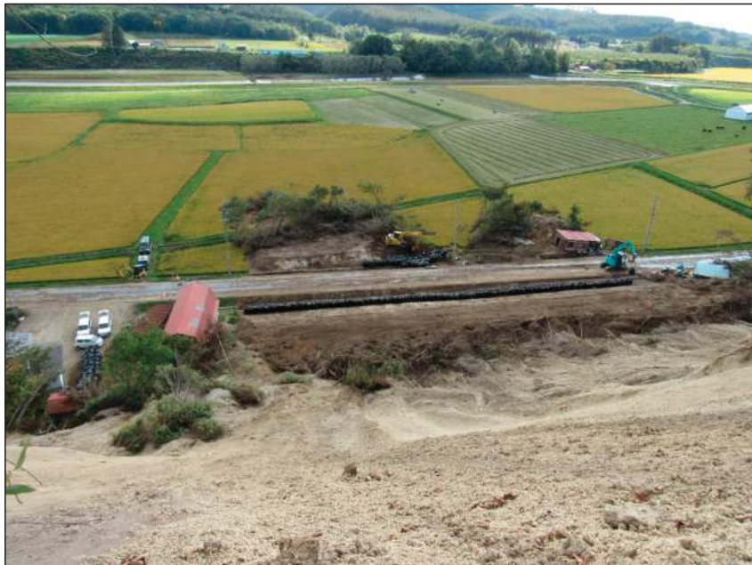
崩壊地斜面の中段(上の写真右寄り★印箇所)から見下ろす。9月29日撮影。
