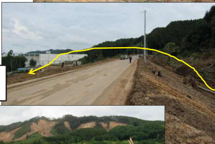
地すべり体の道路乗り越え・堆積(除去)
