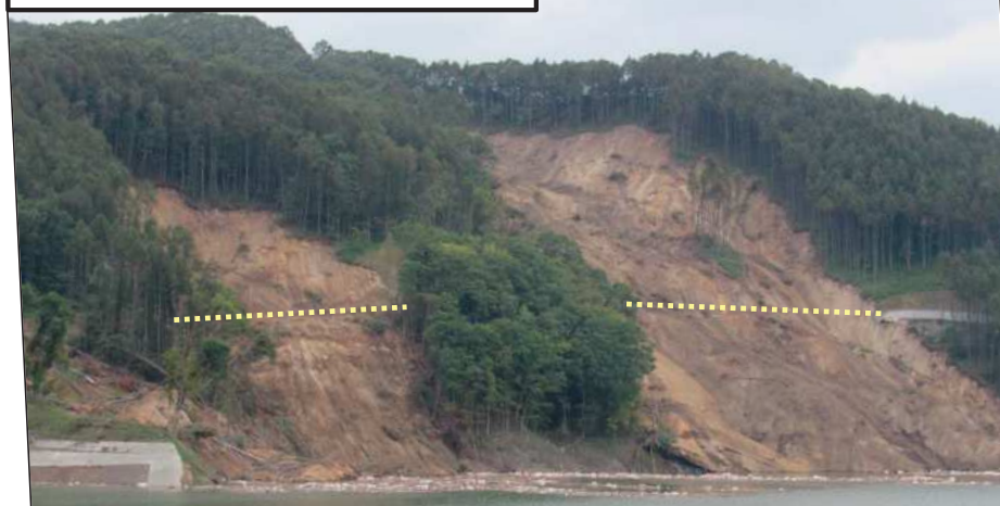
南西側湖岸斜面の崩壊
