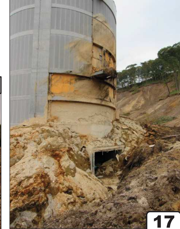
給水塔横のコントロール施設は杭基礎毎倒壊(塔内の貯水の流出で押し流された?)
