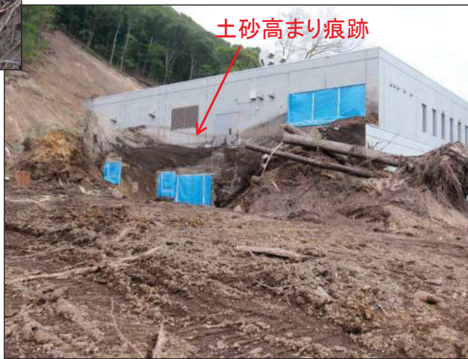
転倒し約70m押し流されたコントロール施設
