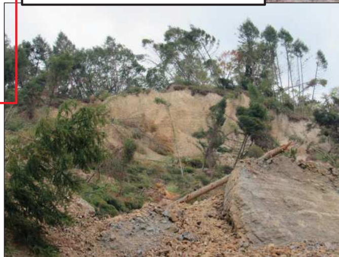
左上の写真の黄色囲み部分の拡大写真。地すべり塊は緩傾斜であることが露頭から分かる
