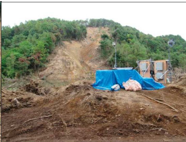
滞水の水位状況を監視中
