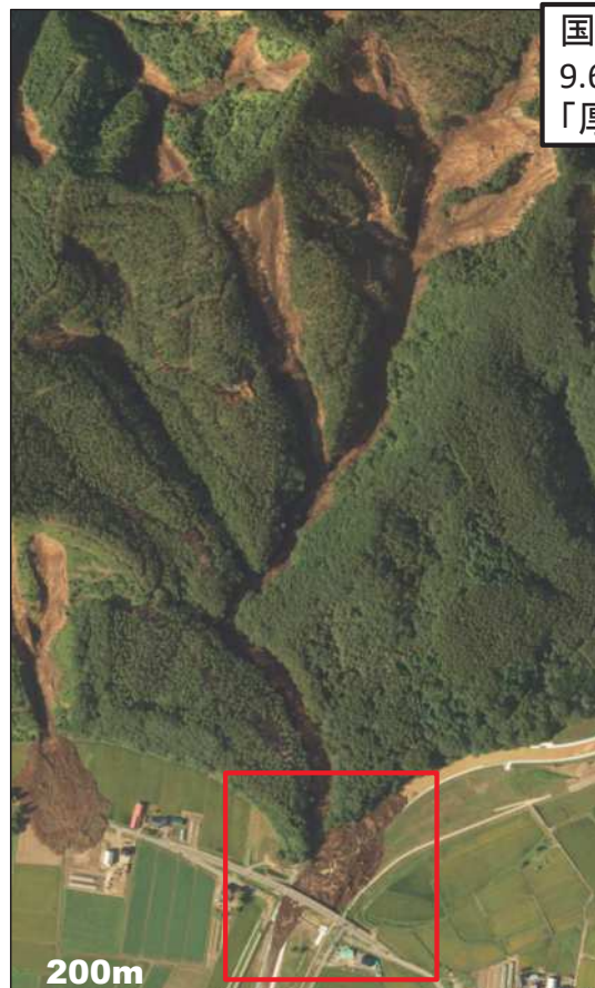
幌内集落北側の空中写真
