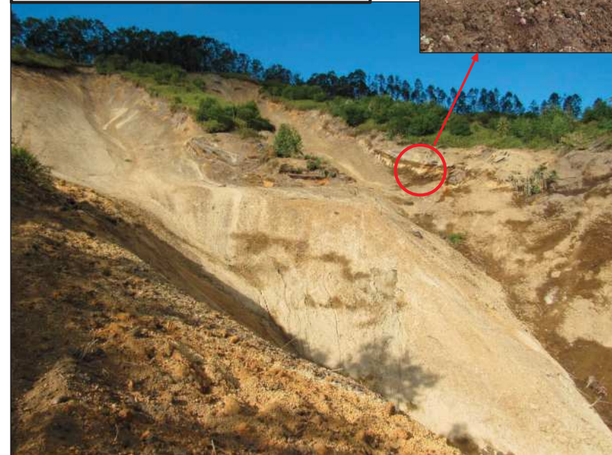
西の崩壊・地すべり体の上部 (2つの枝沢で構成、斜面堆積物の表層が崩落)
