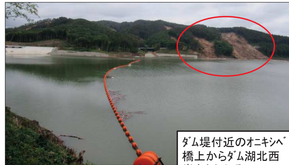
南西側湖岸斜面の崩壊
