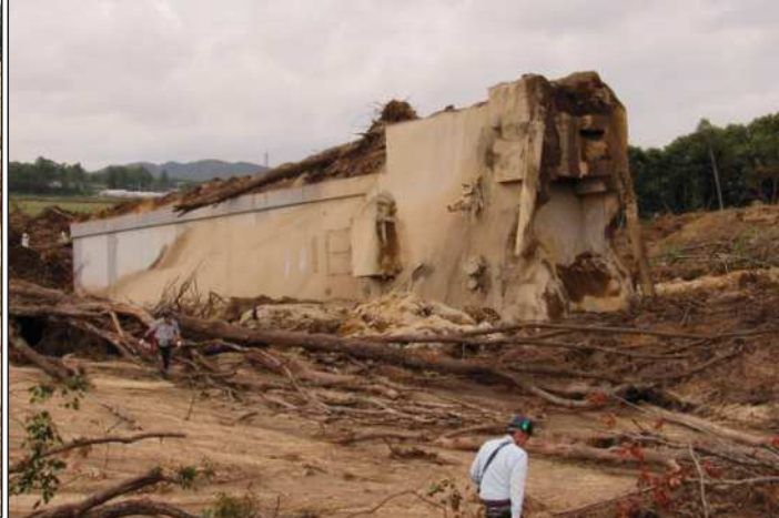
転倒し約70m押し流されたコントロール施設
