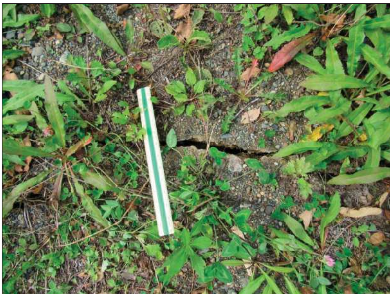
路面亀裂は道路北西側(低地側)にも延びる。
