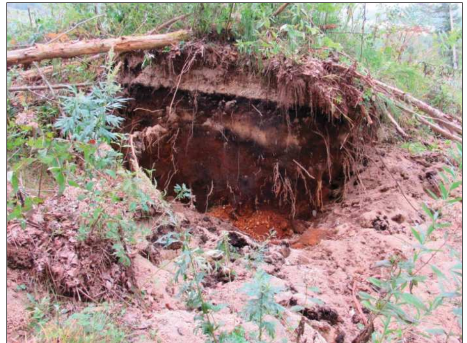
新たに生じた活断層露頭の前面の地すべり発生部の崩壊ブロック( Ta-d 以上の段丘堆積物上部)
