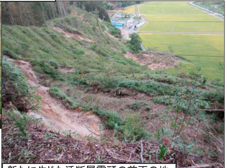
新たに生じた活断層露頭の前面の地すべり発生部。前方には別の崩壊・地すべり体が発生し、水田まで流出。
