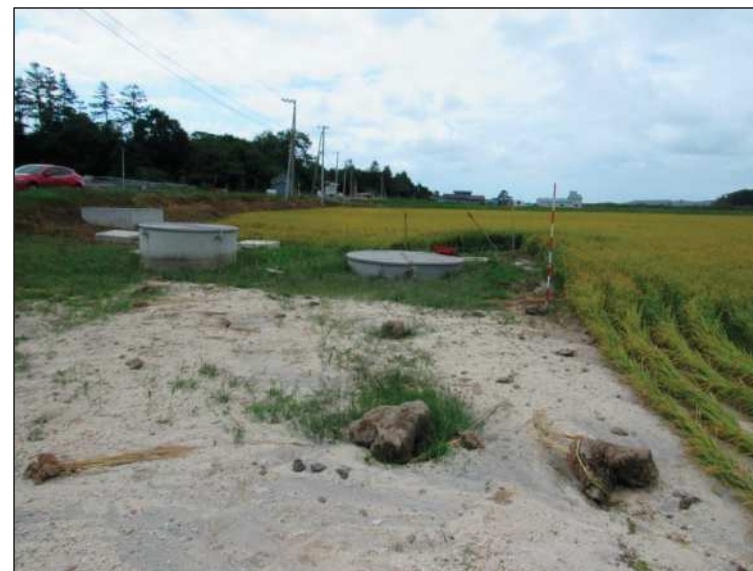
道路に沿って南西方向に30cmあまり落ち込む。上の写真と次のページの説明から、埋設用水路管に沿って地盤変状や噴砂(管路破断)が生じたことが判明。
