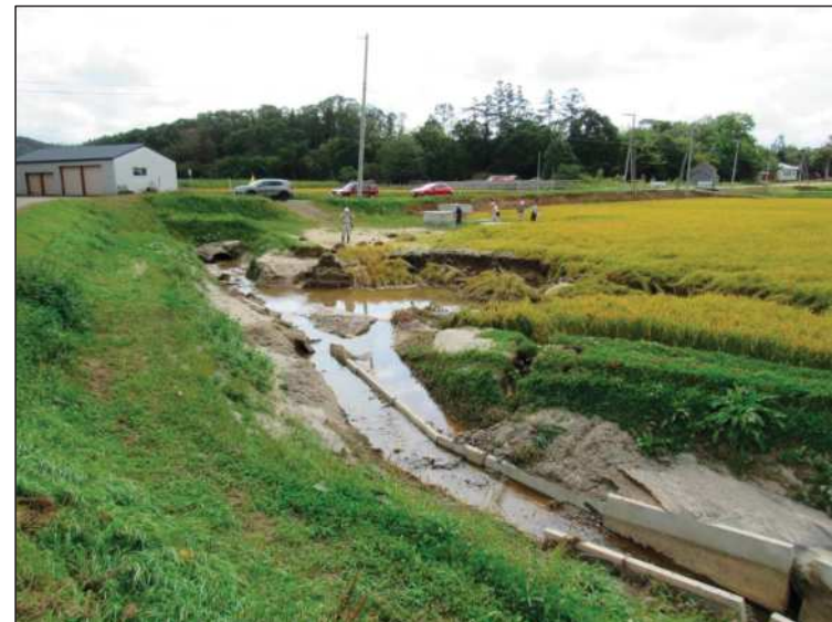
東和噴砂箇所(東和川合流点北東)▲地点。噴砂域の規模は20m×30mにわたり規模が大きい。
