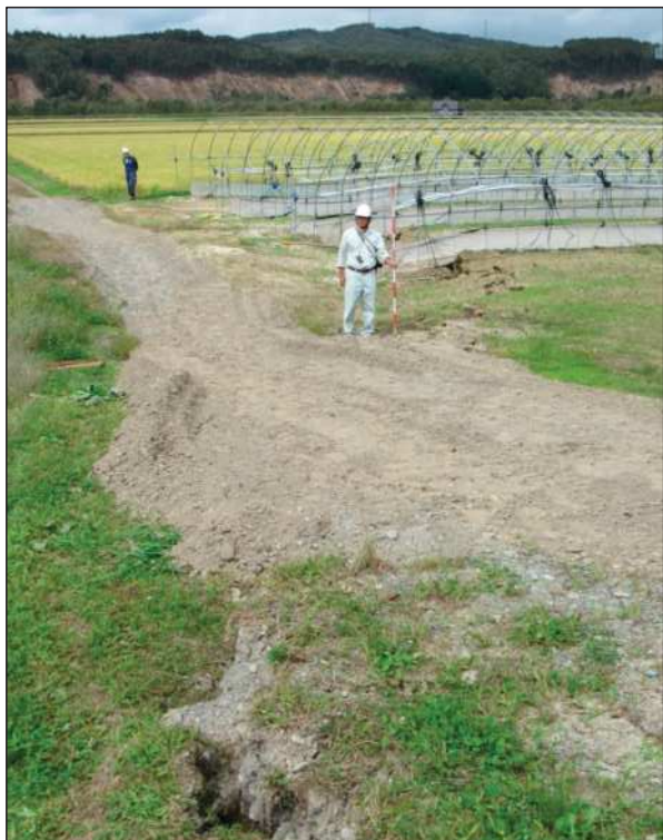
北西へ向かう道路に沿って斜めに横切って北北西方向へ地溝状の数10cmの落ち込みが認められる。埋設管路を反映したものと思われる。前方は吉野地区の崩壊箇所。
