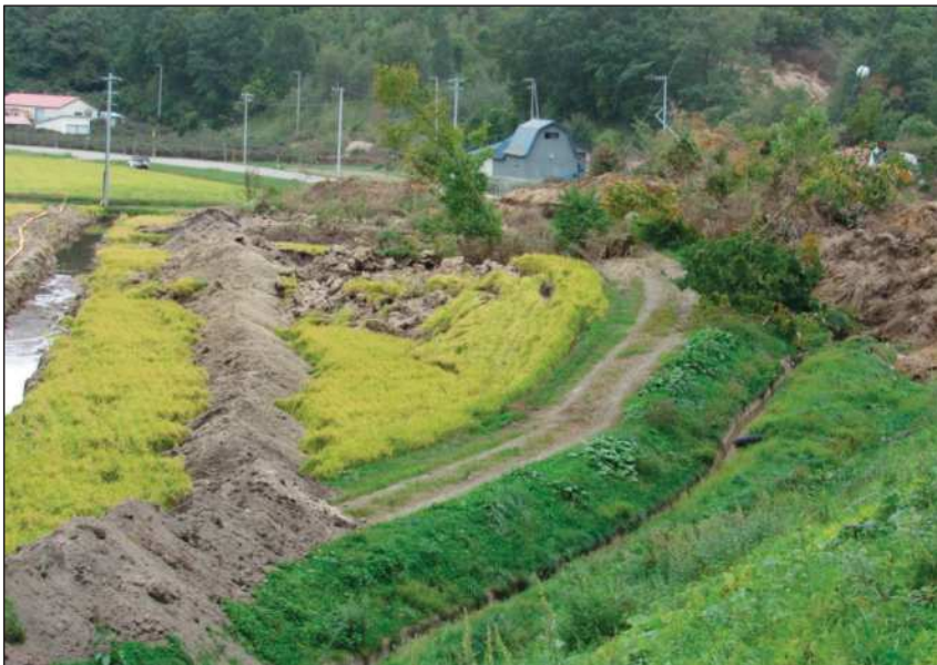
地すべり体が盛り土状の農道側面+用水路壁を押したため、水田表層が押し上げられ変形している。
