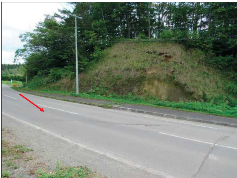
東和三叉路東側切土露頭。新第三系萌別層礫岩・砂岩互層よりなり、50°西傾斜。斜面薄層に亀裂あり。路面を亀裂が斜めに横切る(NNE-SSW方向; 赤矢印)。
