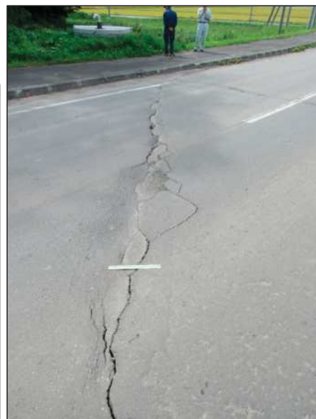
路面を斜めに横切る亀裂。低地部と丘陵地の境界の地形変換部に今回の地震で発生。
