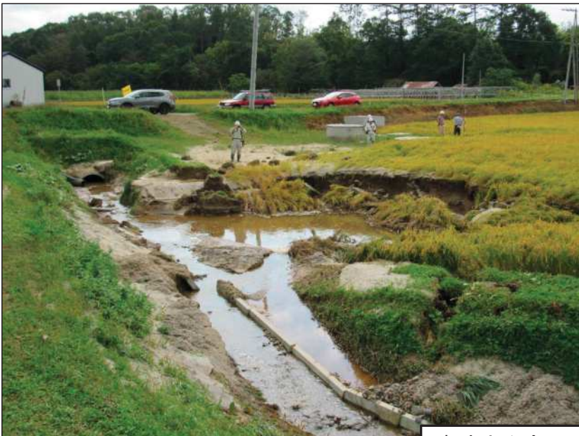
噴砂中心部 (埋設管路の コーナー部で破断 または分離か)
