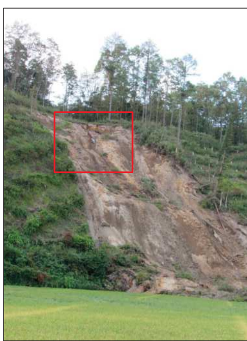
地震で発生した崩壊・地すべり体
