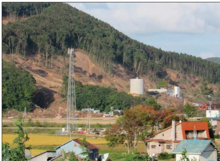
A (櫛山南側斜面～河岸段丘上の崩壊箇所、富里浄水場周辺):主に平滑斜面での崩壊、一部舌状体が耕作地や厚真川に流出する。
