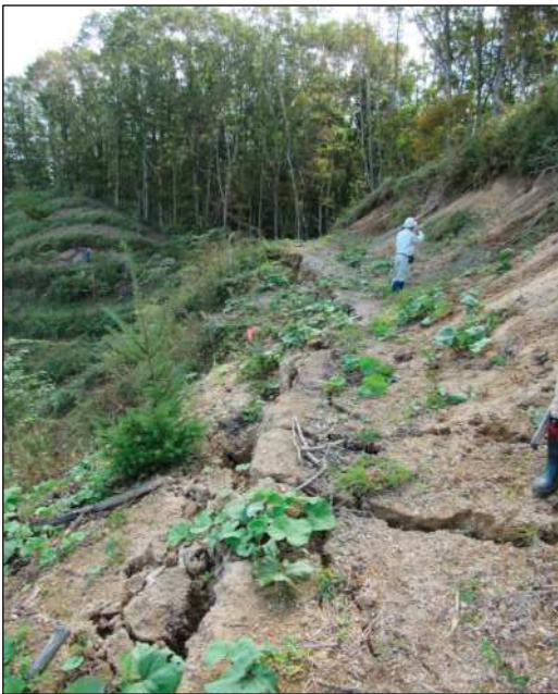
従来の活断層露頭の状況(2016年の調査時から2年が経過;南西へ向かって撮影)。作業道の低地側には地震による亀裂が発生。
