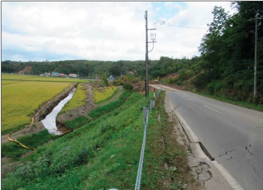
道路を塞ぎ水田に乗り出した地すべりの崩壊箇所(前ページ空中写真の地点5)。溝は災害後に排水のために掘削された。溝断面は本箇所付近が泥炭地であることを示す。
