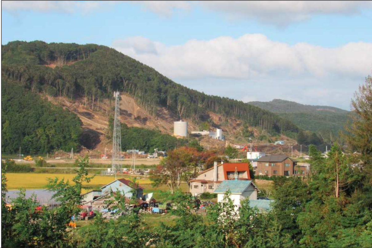
富里櫓山南側斜面～河岸段丘上の崩壊箇所(8月完成の富里浄水場)を撮影
