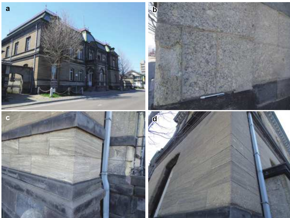
第12図 小樽軟石の活用例としての旧日本郵船株式会社小樽支店（国指定重要文化財）と石材としての小樽軟石の産状. a: 小樽軟石の活用例:旧日本郵船株式会社小樽支店（国指定重要文化財）. 1904（明治37）年に着工し1906（明治39）年に竣工した、明治時代の洋風石造建築を代表する建造物の1つで工部大学校（現東京大学工学部）第1期生の佐立七次郎が設計した. b: 石材としての小樽軟石（軽石凝灰岩）の産状. 石材業者はこのような小樽軟石を「玉目」と称している. c: 石材としての小樽軟石（ラミナの発達した砂質凝灰岩）の産状. 石材業者はこのような小樽軟石を「縞目」と称している. d: 石材としての小樽軟石の産状（玉目と縞目の石材が程よく組み合わされて美観を呈している）.
