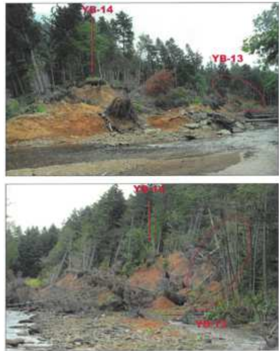
第18図 山田温泉東側大露頭（2016年8月台風による崩壊地；2017年9月中旬撮影）。上：下流から撮影。下：上流から撮影。
