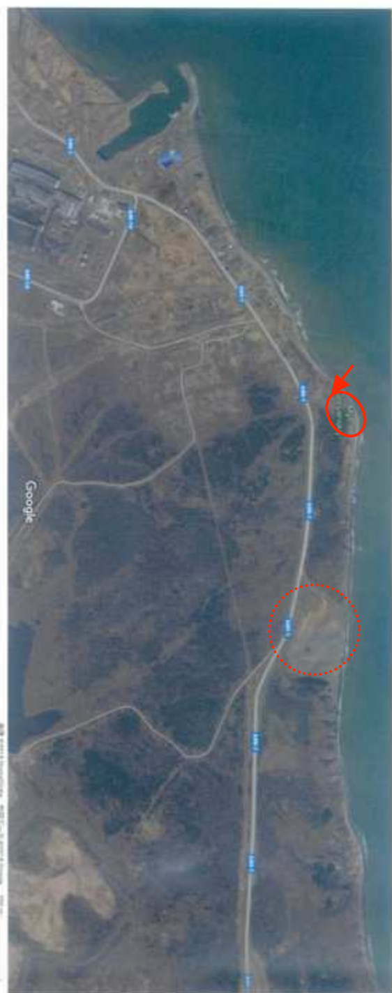
第 32 図. レルモントブカ南東海岸付近の航空写真 (グーグルマップ 2018.5), 引用・加筆. 赤矢印: R1 地点 (ゴリヤンスキー岬北側海岸部). 赤実線囲み: R2 地点 (ゴリヤンスキー岬付近海食崖) 赤点線囲み: R3 地点 (碎石場). 写真上部には石炭火力発電所と温排水放出水路が見える.
