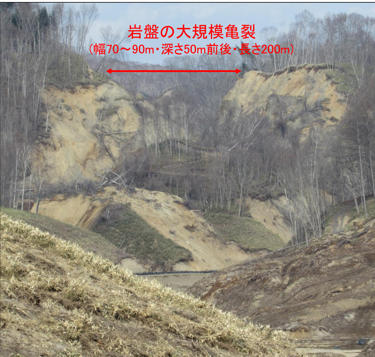
厚真町日高幌内川上流で発生した岩盤すべり(巨大岩盤すべり排水路工事個所の上流側)
