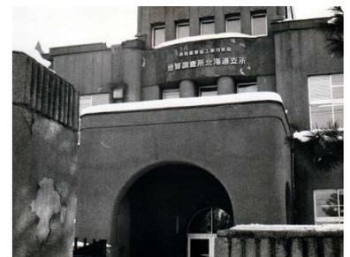
支所玄関の様子(表面のコンクリートが剥がれた門柱修理要求用の写真)。
